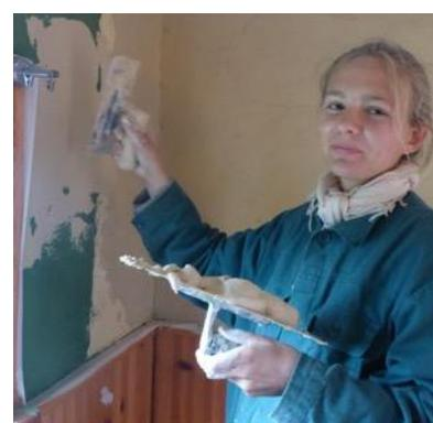
Auftragen der obersten Putzschicht, aus der dann ein grünes Motiv ausgekratzt wird.
