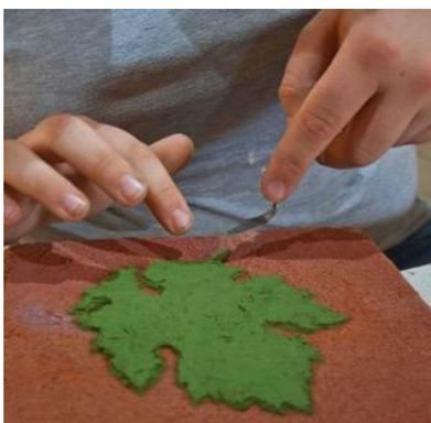
Schablonieren eines Motivs mit farbiger Putzmischung
