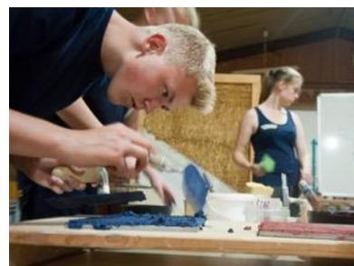
Das Aufziehen einer farbigen Putzschicht auf einer Musterplatte
