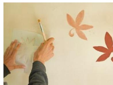
Aufschablonieren eines Motivs mittels selbst hergestellter Schablone und Lehmfarbe
