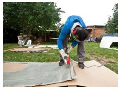
Zuschnitt des Blechs eines Caravans für die Beplankung der Seitenwände
