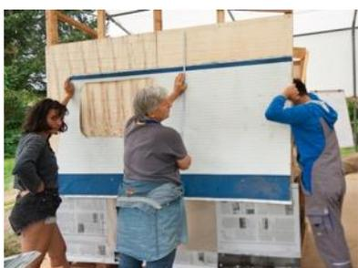
Montage von Offsetdruckplatten und Autoblech an eine Seitenwand
