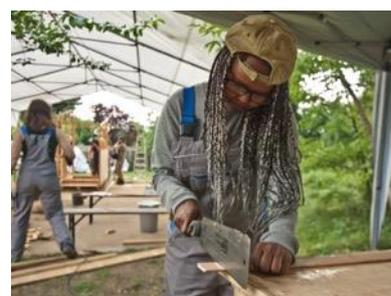
Zusägen von gebrauchten Sperrholzplatten für die Seitenwände
