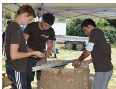
Aufmauern des Tandoor mit Ziegelsteinen und Lehmörtel
