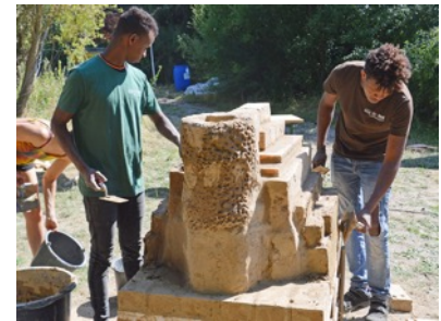
Mauern des Ofens mit Schornstein
