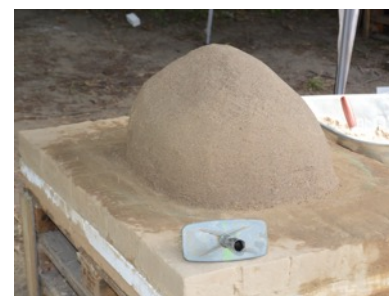
Die Negativform aus Sand für den Ofen aus Lehmbröten
