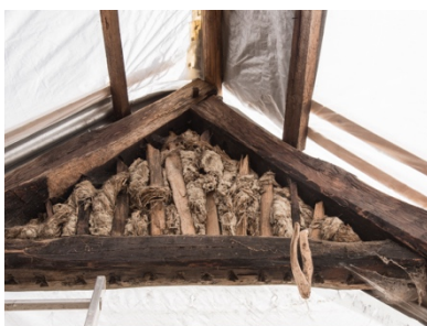
Auf dem Dachboden wird die Lehmzöpfe-Technik entdeckt
