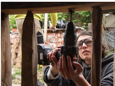
Bohrung des oberen Riegels zum Einsetzen der Staken
