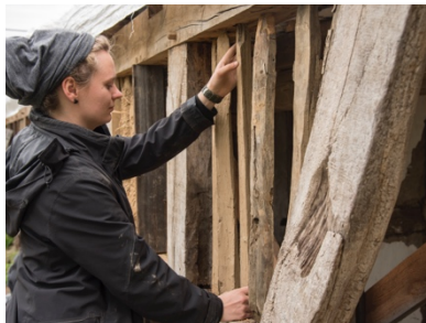
Einpassen der vorher zugesägten und angespitzten alten Staken
