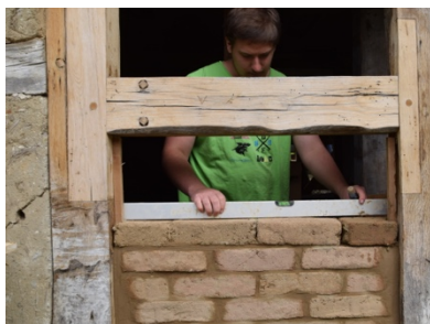
Ausmauern von einem Gefach
